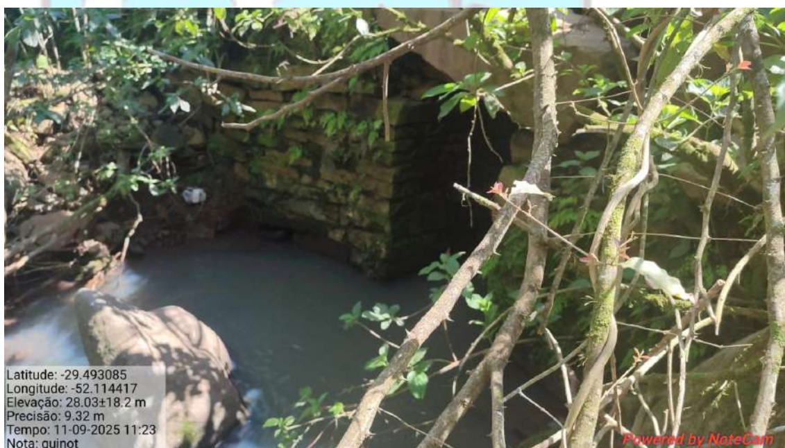
Imagem 4 – Estrutura apoiada sobre pedras naturais
