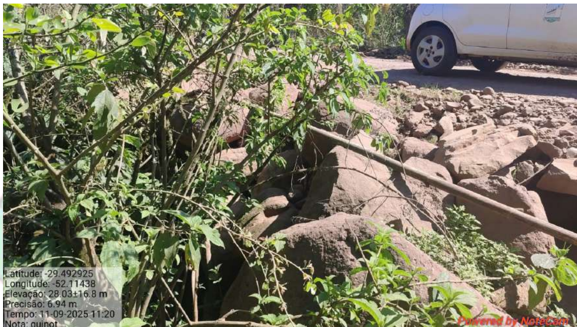
Imagem 3 – Erosão de bordas
