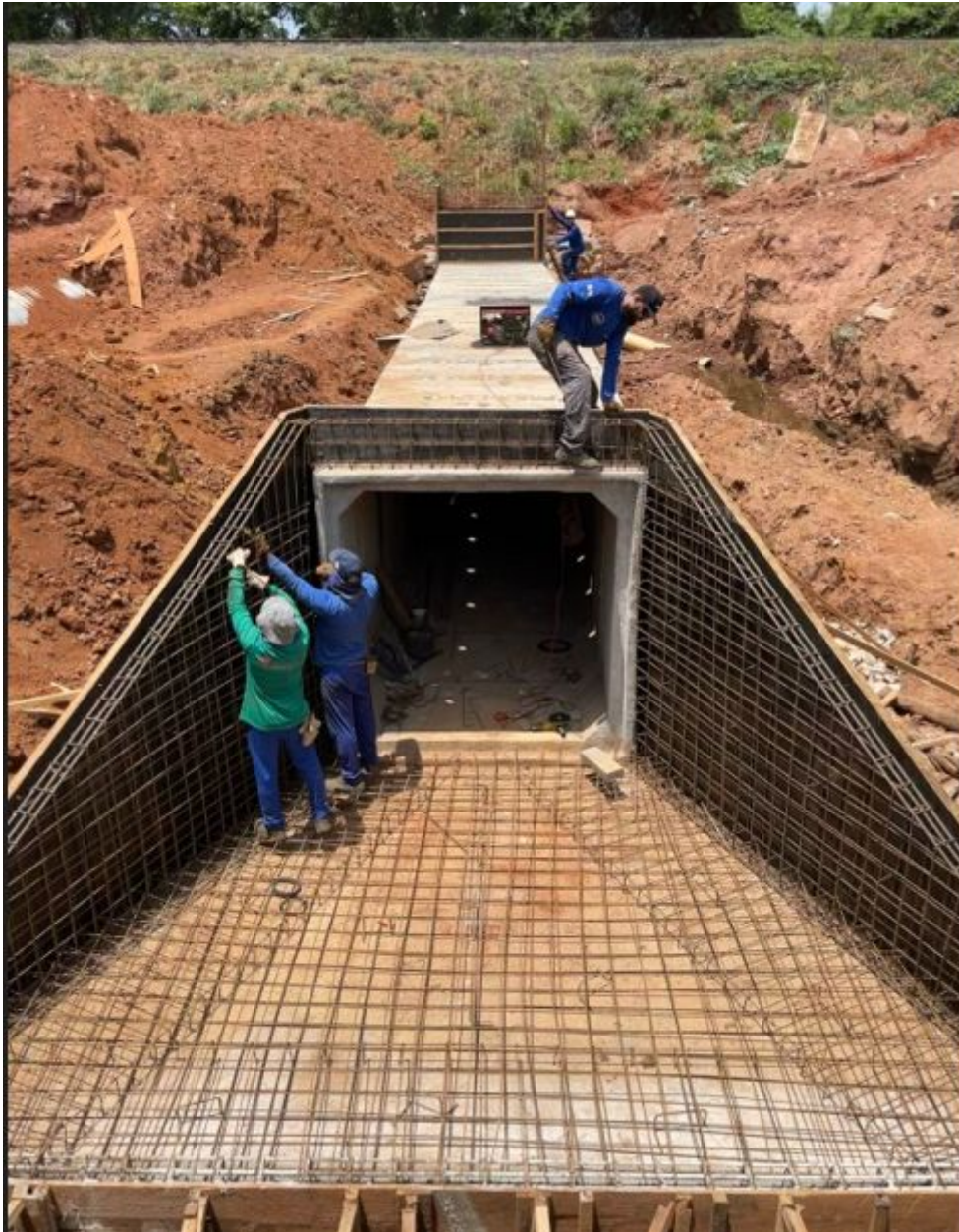
Boca de bueiro celular
