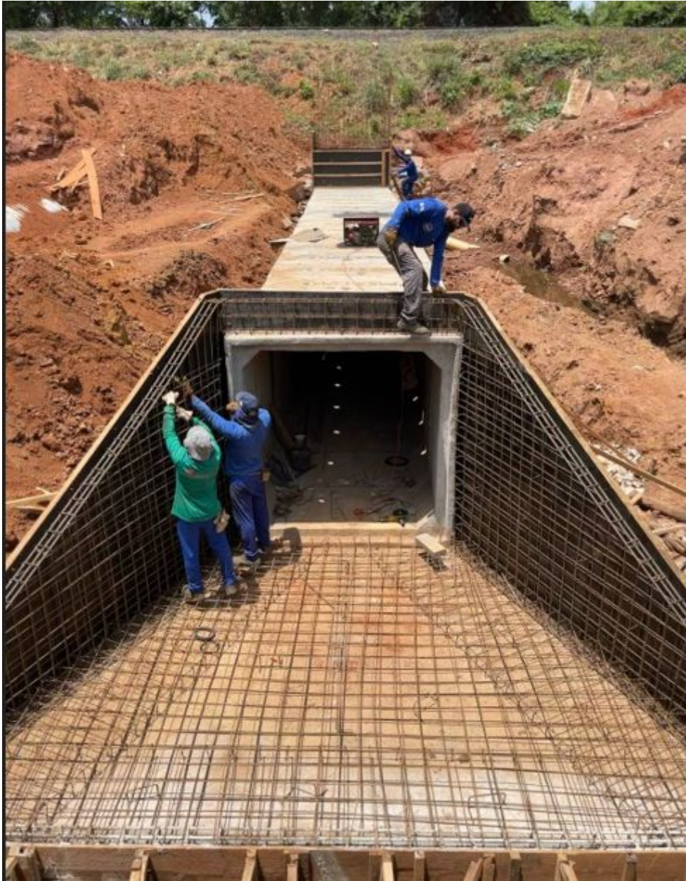
Boca de bueiro celular
