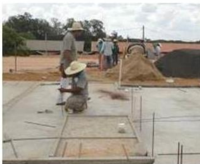
FIGURA 16 – Elemento de fundação com planicidade adequada
