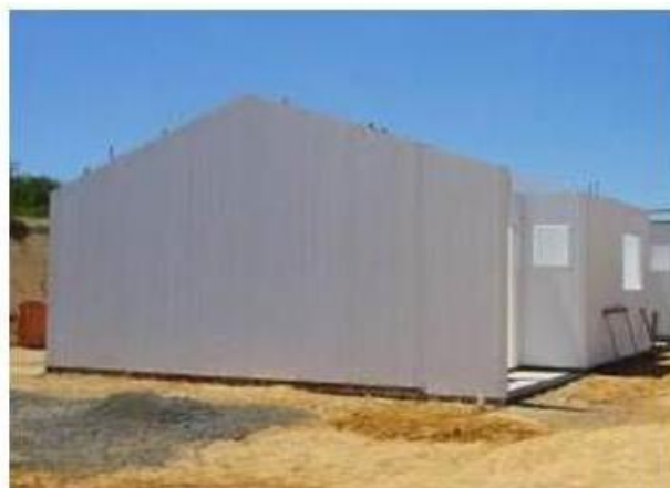
FIGURA 22 – Painéis de PVC concretados
