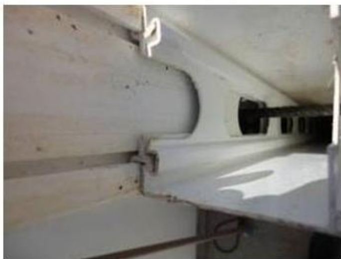
FIGURA 20 – Ferragem posicionada na região da contra-verga
