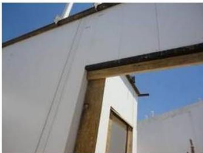
FIGURA 21 – Escoramento de aberturas de portas para concretagem
