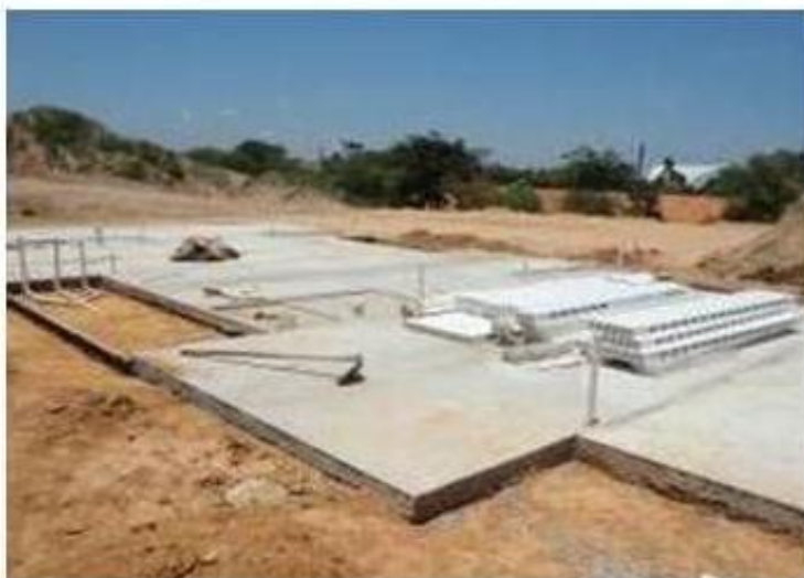
FIGURA 16 – Elemento de fundação com planicidade adequada
