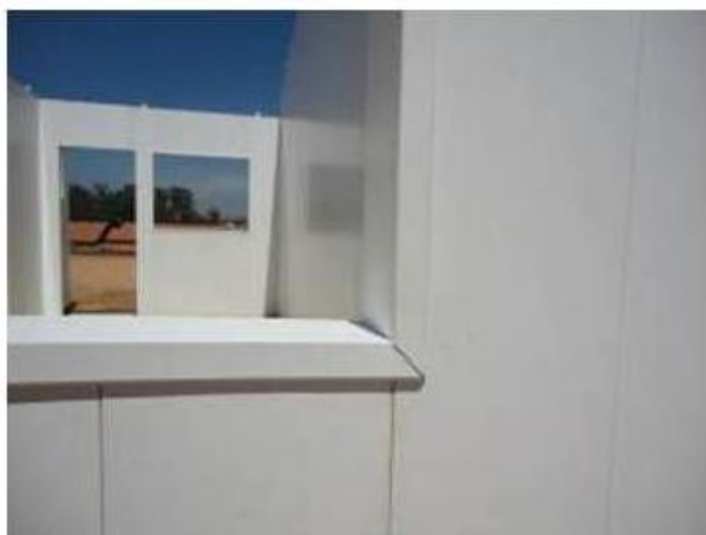
FIGURA 23 – Abertura das janelas com acabamentos em PVC
