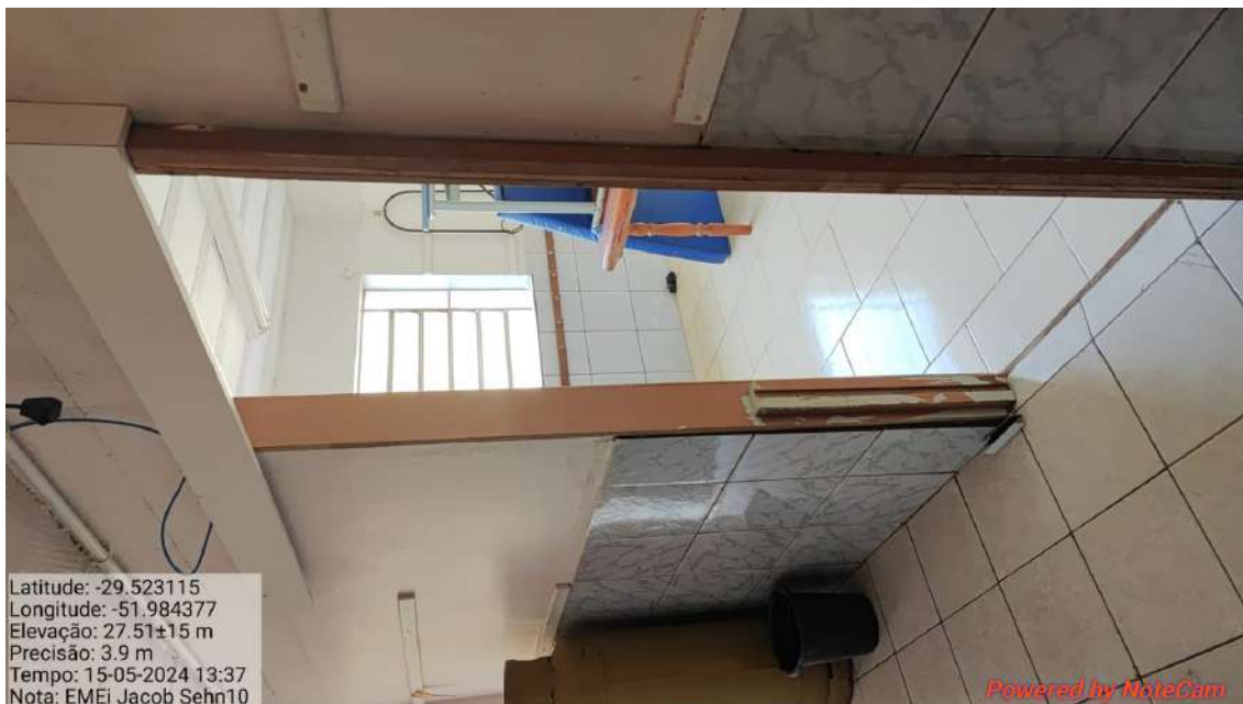
Imagem 10 – Porta danificada folha suspensa , previsto remoção da esquadria na totalidade e instalação de porta de alumínio de correr, prevista no Item= 1.2.10
