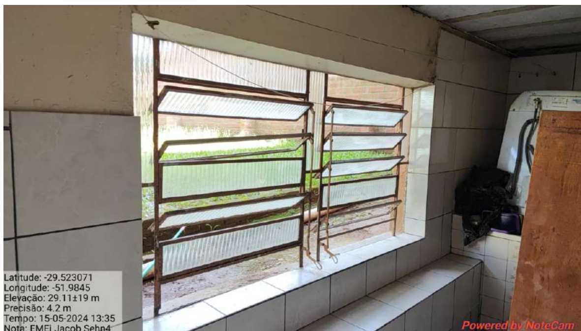
Imagem 07 – Previsto a remoção da esquadria, foi muito danificada, ficou abaulada e com vidros quebrados. Previsto a remoção no item: 1.2.1 e a substituição nos itens: 1.2.8 e 1.2.9
