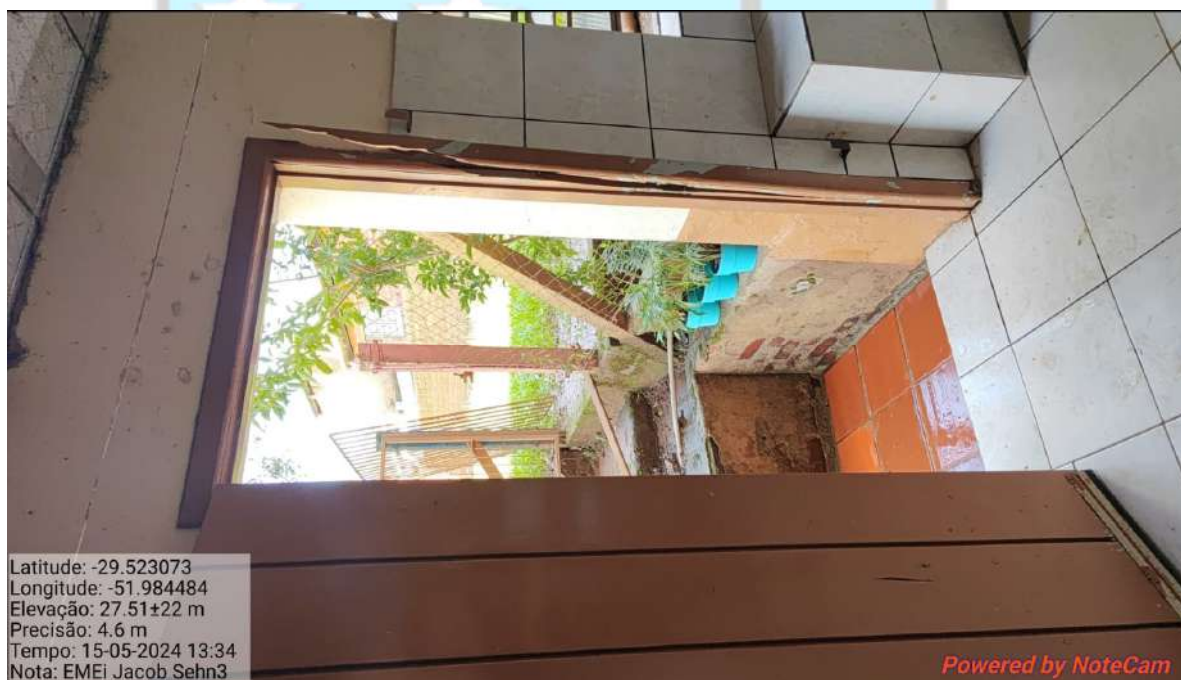
Imagem 09 – Porta danificada, previsto remoção e instalação de porta de alumínio fechada com lambri, prevista no Item= 1.2.11
