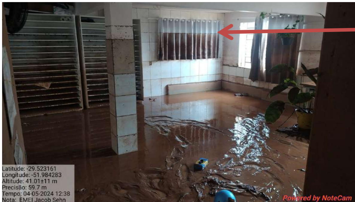
Imagem 05 – Marca da altura da enchente no pavimento térreo da EMEI em torno de 1,90m de altura.
