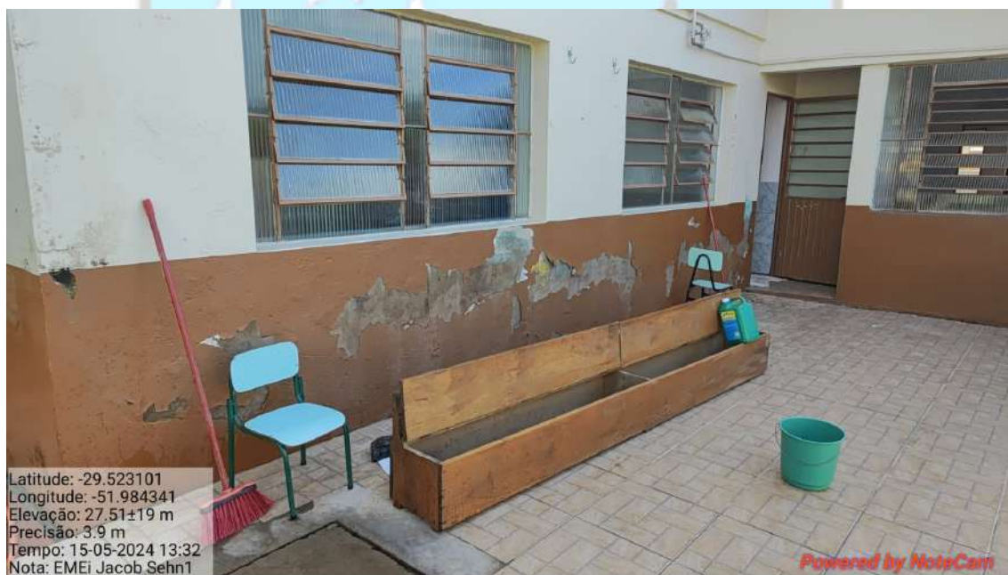
Imagem 08 – Previsto lixamento e pintura das esquadrias no item 1.2.13 e 1.2.14 do pavimento térreo da edificação, patologias causadas após a cheia.
