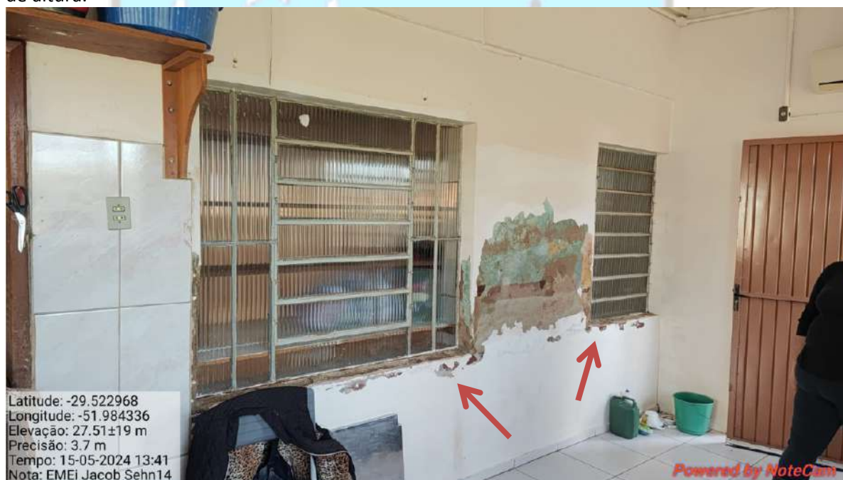
Imagem 06 – Previsto a remoção dessas 2 esquadrias com fechamento em alvenaria, chapisco, emboço e pintura previsto nos itens: 1.2.3 até 1.2.7. As mesmas estão muito imperadas e sofreu patologias no vão da alvenaria.
