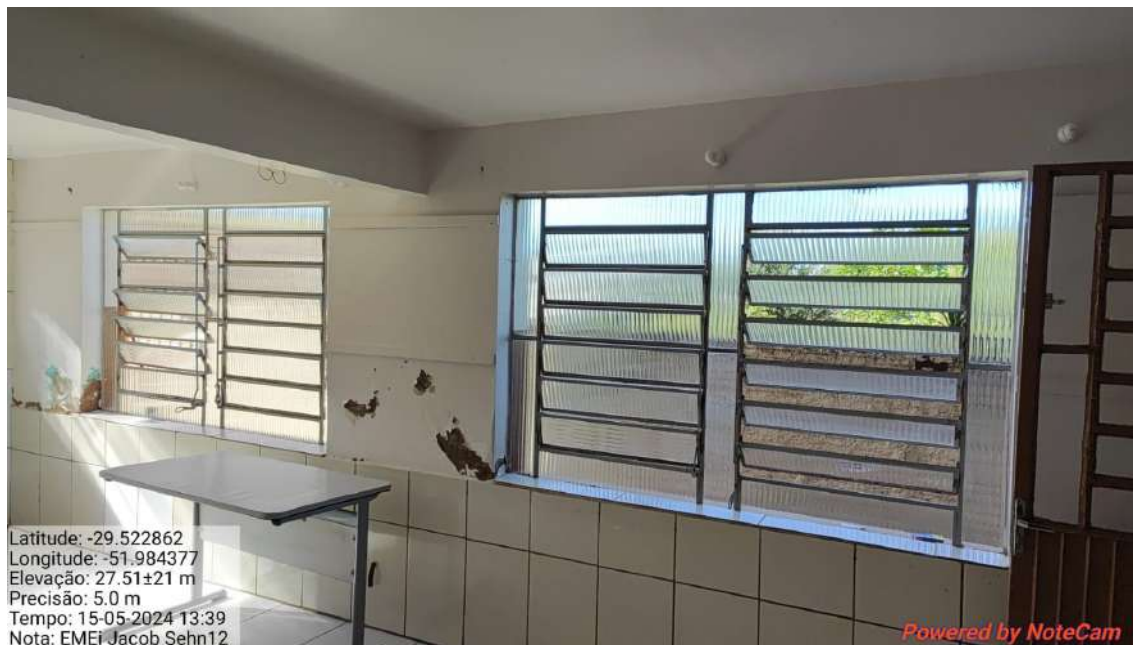
Imagem 08 – Diversas esquadrias basculantes imperadas, não abrem, previsto serralheiro para lubrificar e desemperrar no item 1.2.12.
