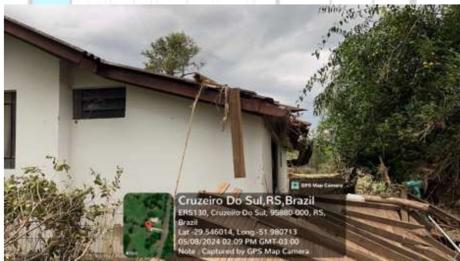
Imagem 15 – EMEF Arthur Eckert. Parte do telhado fora danificado, sendo necessário a substituição.
