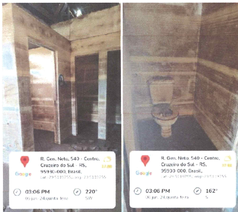
Imagem 21 e 22– Limpeza dos sanitários, pintura interna, substituição das louças e metais e luminárias - serviços previstos no item 1.8 da Planilha Orçamentária.
