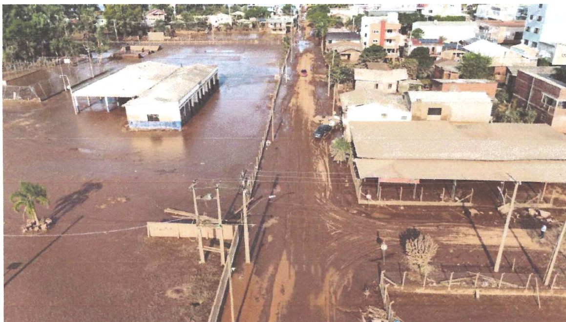
Imagem 24— Limpeza do pátio e colocação de pav's, foi estipulado este pavimento a fim de facilitar a limpeza caso ocorra outro episodio de cheia, assim como evitar a perda do material aplicado - serviços previstos no item 1.9 da Planilha Orçamentária
