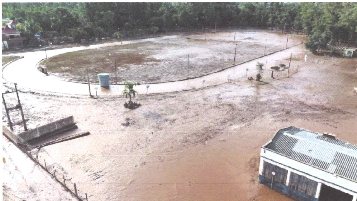
Imagem 03 – Pista Atlética imagem aérea com drone – Ficou submersa de lodo, prevista a remoção do material e emprego de novo material para restabelecimento das atividades esportivas– Previsto restabelecimento no item 1.1 da Planilha Orçamentária.
