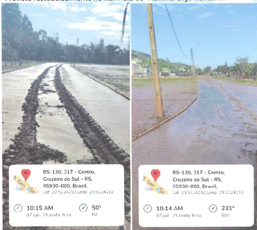
Imagem 04 e 05 – Pista Atlética – Ficou submersa de lodo, prevista a remoção do material e emprego de novo material para restabelecimento das atividades esportivas– Item 1.1 da Planilha Orçamentária.
