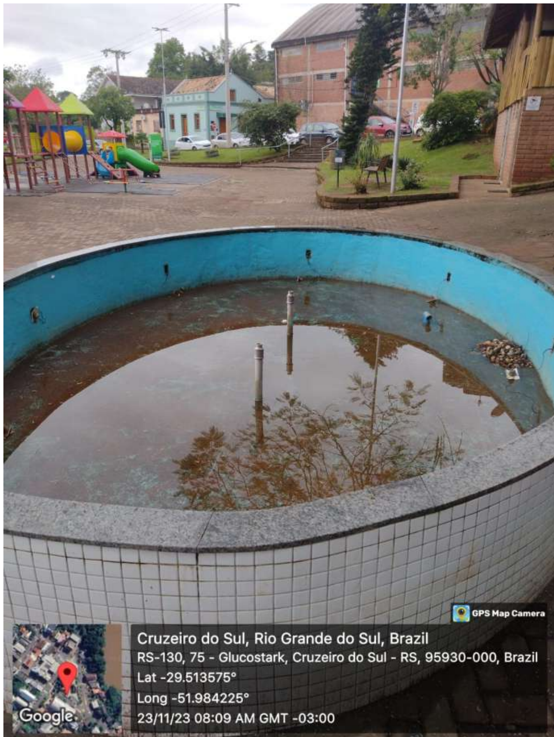
Imagem 07 – Espelho d’água, limpeza com lava jato conforme (item 1.2.2 do orçamento) danificou a parte elétrica, realizar uma revisão com reinstalação. (Itens 1.2.1 do orçamento)
