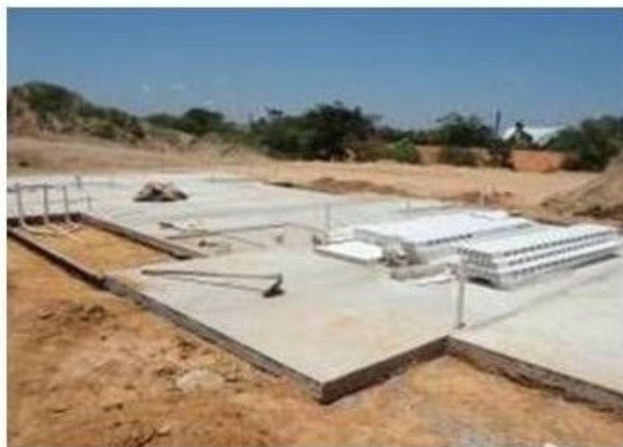
FIGURA 9 – Elemento de fundação com planicidade adequada
