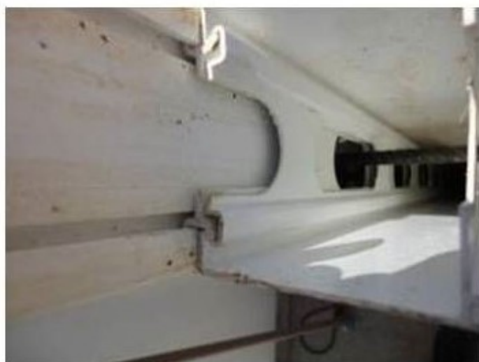
FIGURA 13 – Ferragem posicionada na região da contra-verga
