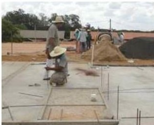
FIGURA 10 – Fixação das barras de ancoragem à fundação com adesivo epóxi
