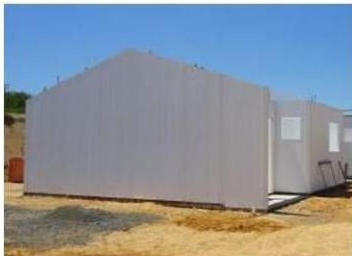
FIGURA 15 – Painéis de PVC concretados
