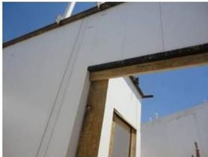
FIGURA 14 – Escoramento de aberturas de portas para concretagem
