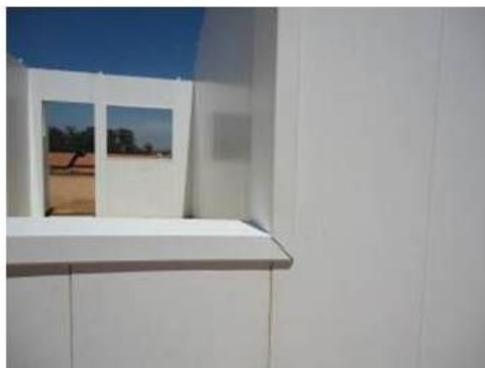
FIGURA 16 – Abertura das janelas com acabamentos em PVC
