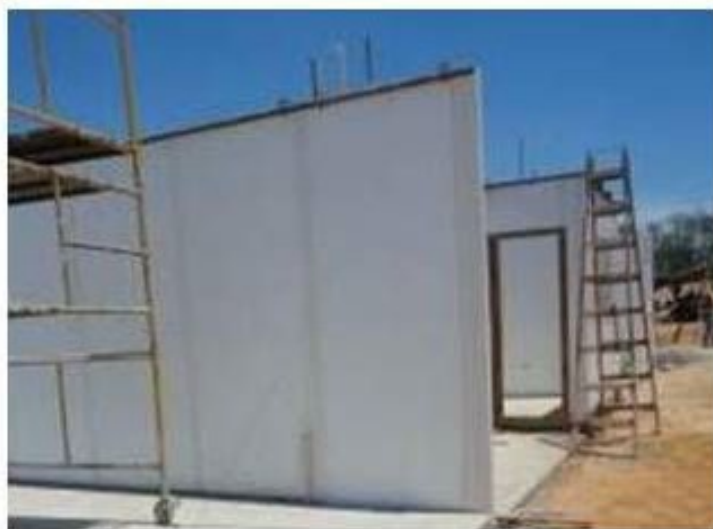
FIGURA 12 – Painéis de PVC posicionados e escorados
